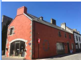
Chantier réalisé par J-P Ropars
